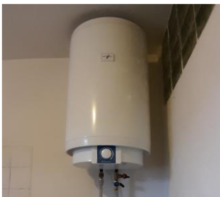
Obrázok 15: Elektrický bojler
