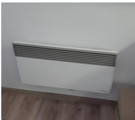
Obrázok 13: Elektrický konvektor
