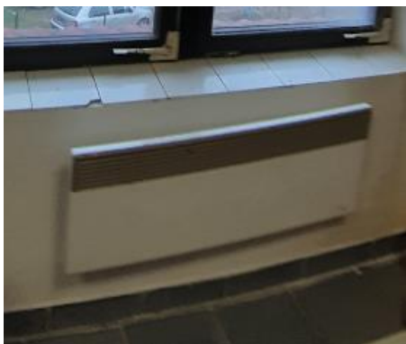
Obrázok 11: Elektrický konvektor
