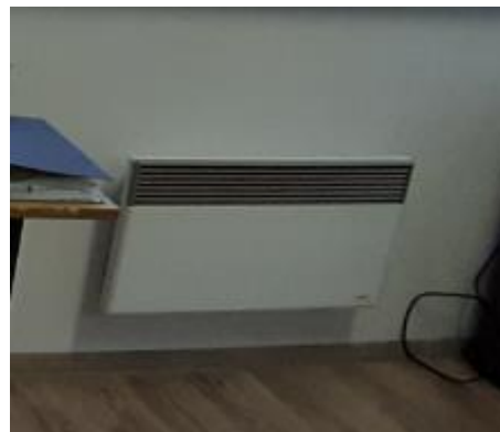
Obrázok 14: Elektrický konvektor
