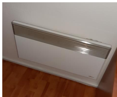
Obrázok 12: Elektrický konvektor
